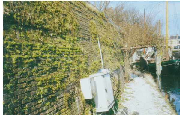
Abb. 1 Fotografie der Stützmauer, wasserseitig
